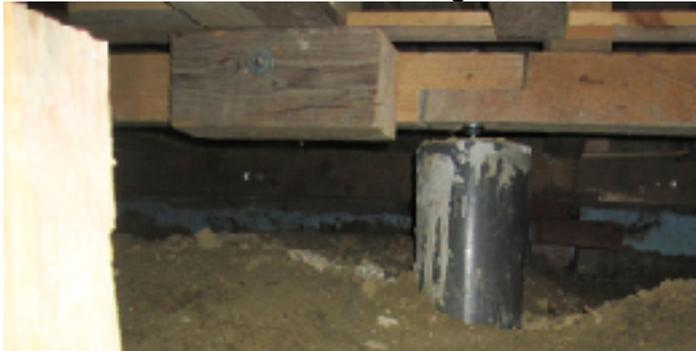
Angesichts dieser Schätze kam schnell die Idee auf, den seit langem ersehnten Gang zwischen den Durchfahrten mit diesem Material herzustellen. Die notwendigen Fundamente sollten wie bei einem schwedischen Sommerhaus ausgeführt werden: Ein tiefes Loch graben, den Boden des Loches mit 15cm Beton bedecken, ein HT oder KG-Rohr mit 15 cm Durchmesser auf
