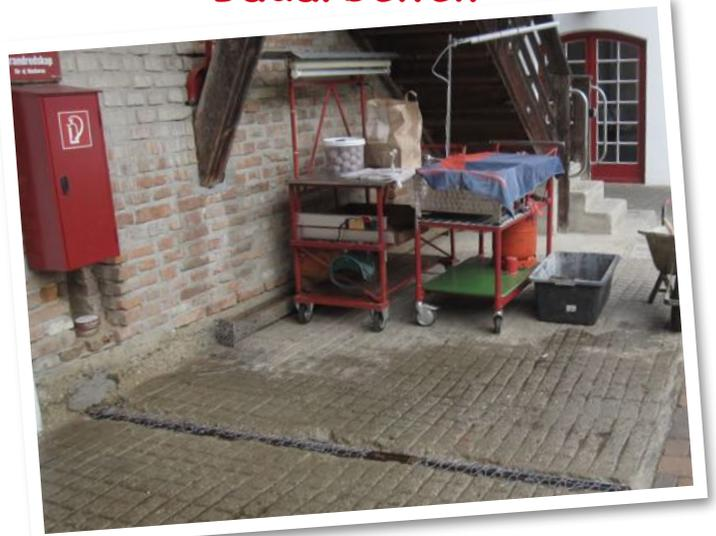
Es ging um die Betonplatte, das nasse Bauteil auf dem Foto, das in Wirklichkeit eine Güllegrubendecke ist. Über einem Stahlträger war der Beton abgeplatzt. Das ist nicht schön, denn jetzt rostet
