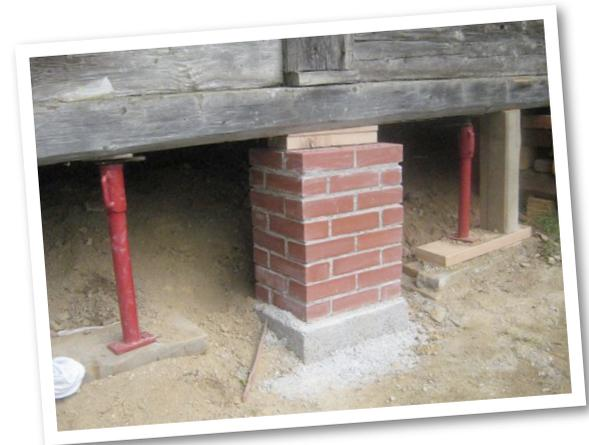
Die zweite Baustelle lag an der Südseite des Stadels. Dort haben wir vier frostsichere Fundamente betoniert und Punktfundamente aufgemauert. Der Stadel war in diesem Bereich, soweit es ging, angehoben worden. Eine gewisse Neigung ist uns aber erhalten geblieben.
